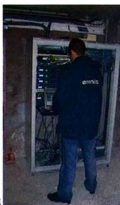
A Paris, Erenis a raccordé 900 immeubles à son réseau de fibre optique.
